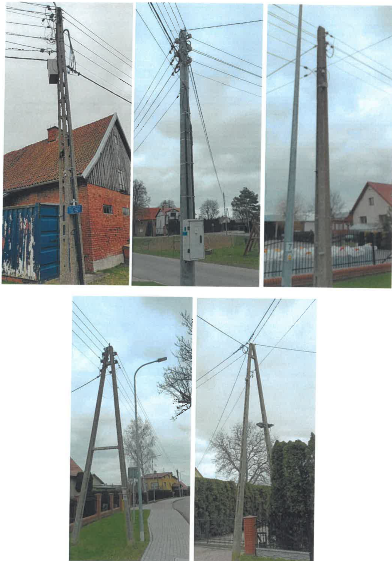
Zdj. 3 Zdjęcia istniejących słupów nr 401, 402, 403, 404 oraz 402/2 przeznaczonych do wymiany
